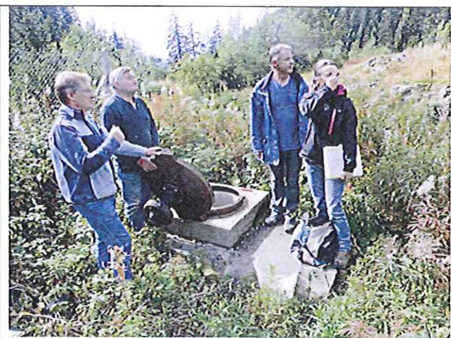
Photo 7 : Prévourey, vue de l'extérieur du captage
