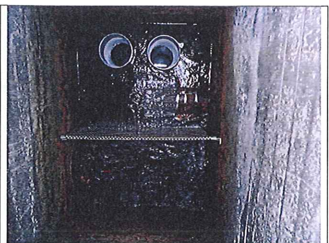
Photo 8 : Prévourey, vue de l'intérieur du captage
